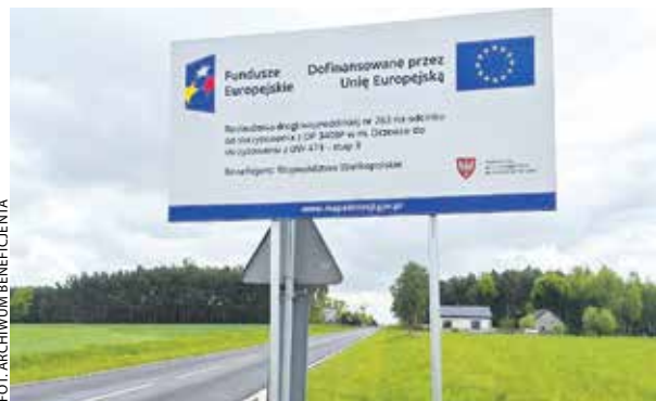
Rozbudowa DW 263 w Drzewcach, gmina Dąbie.
