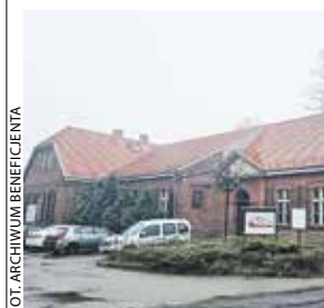
Na modernizację czeka m.in. zabytkowy budynek Ośrodka Kultury w Wieleniu.
