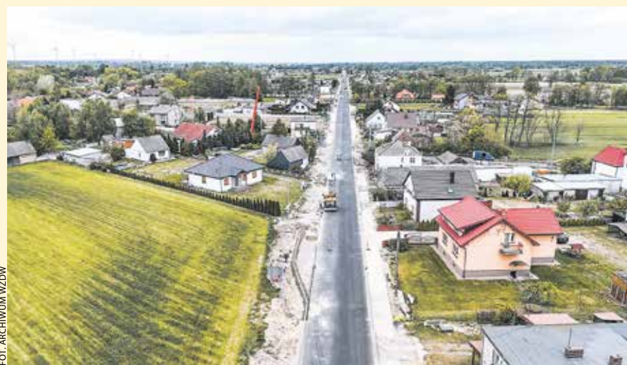
W zdecydowanej większości przebieg DW 442 prowadzi przez pola i dość gęstą zabudowę wsi i małych miast. Na zdjęciu – remont drogi w miejscowości Ruda Wieczyńska.
