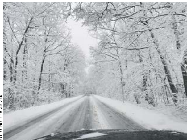
Na bieżące utrzymanie dróg i mostów WZDW w Poznaniu wydał w latach 2020-2025 ponad 547 mln zł.
