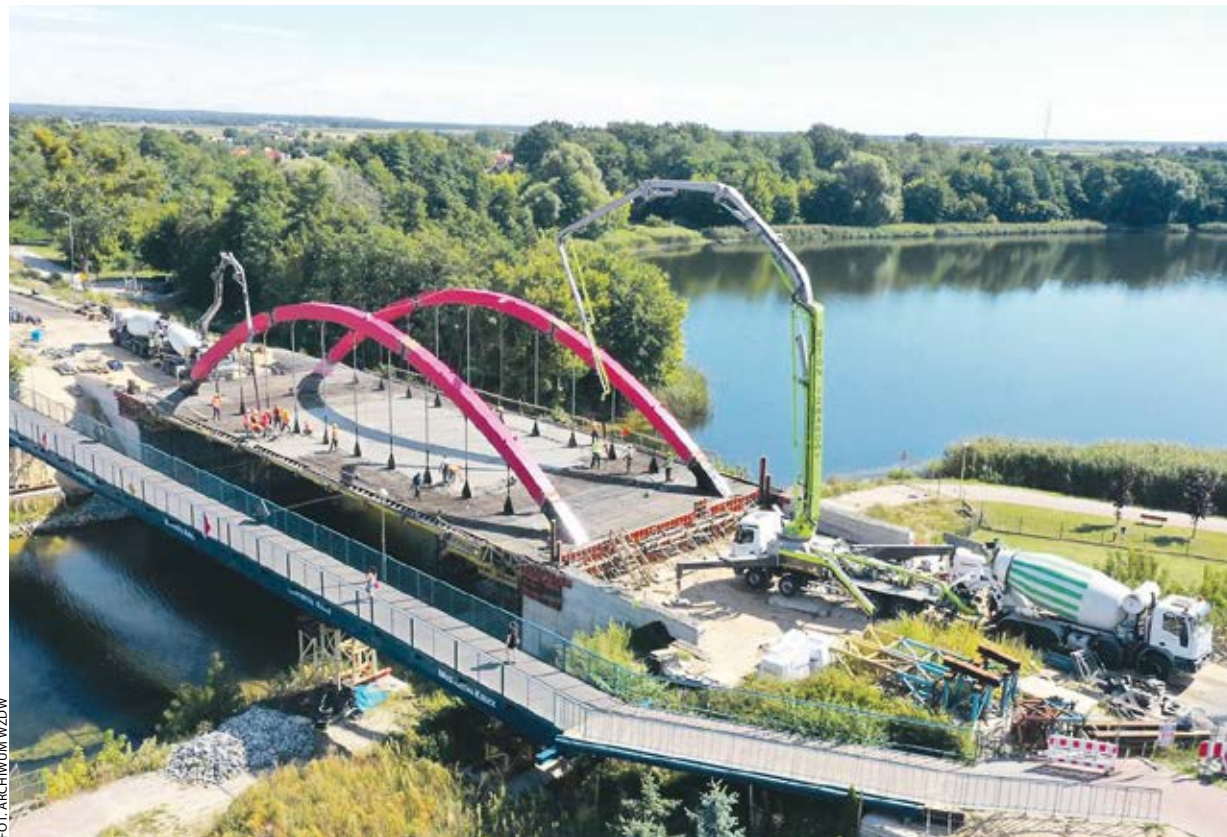
Wśród dofinansowanych przez UE projektów znajduje się np. rozbudowa DW 263 w Ślesinie, gdzie powstaje nowy, niemal 65-metrowy most, z którego mieszkańcy powiatu konińskiego i przyjezdni będą mogli korzystać już w drugim kwartale 2026 r.
