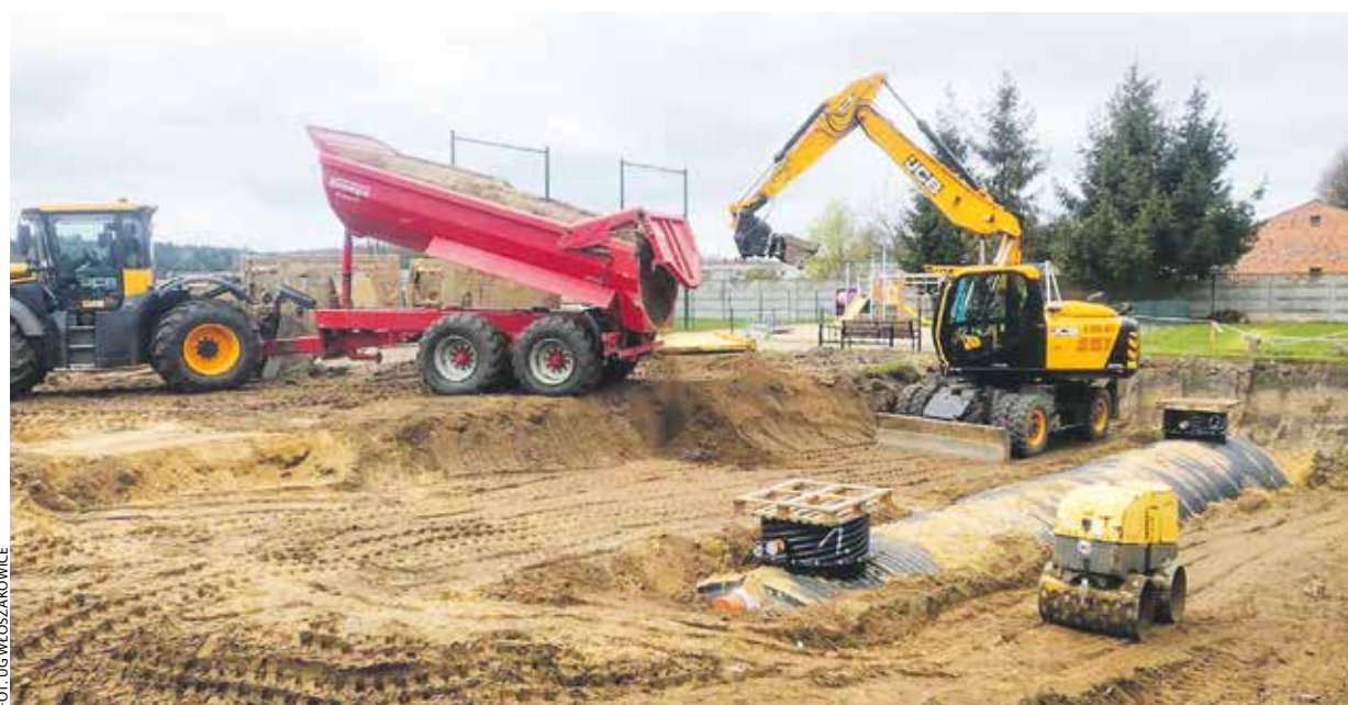
Budowa zbiornika retencyjnego w Jezierzycach Kościelnych w gminie Włoszakowice to jeden z elementów projektu dofinansowanego z PROW 2014-2020.
