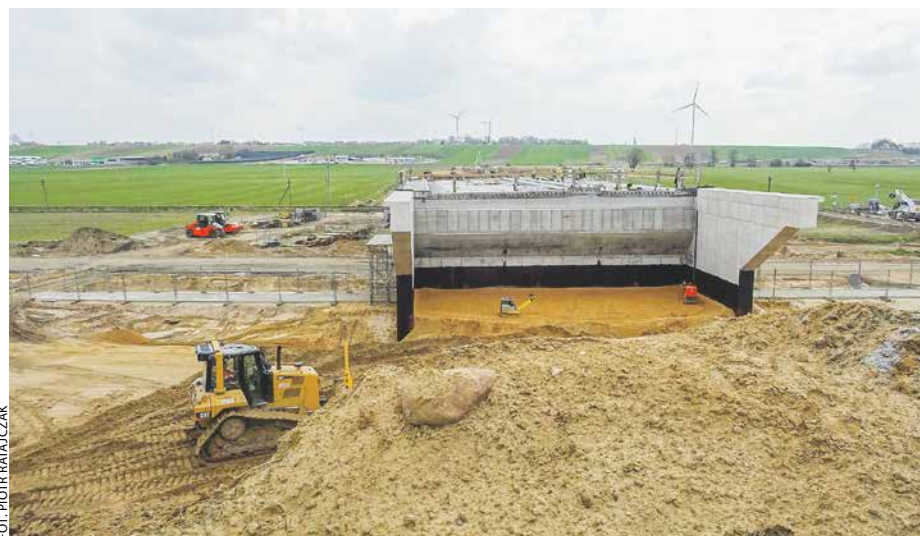
Mosty, wiadukty czy też inne obiekty inżynierskie są sporym wyzwaniem dla drogowców.
