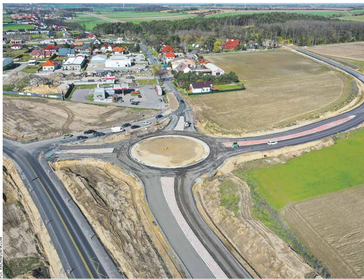
Budowa obwodnicy Gostynia, kosztująca blisko 140 mln zł, to najdroższa jak dotąd inwestycja drogowa samorządu województwa.
